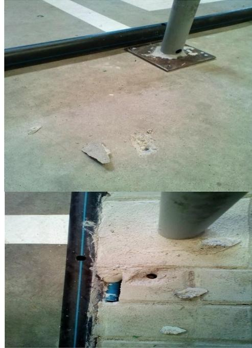
Imagem 52 - Abertura de furos para fiação de cabos.
