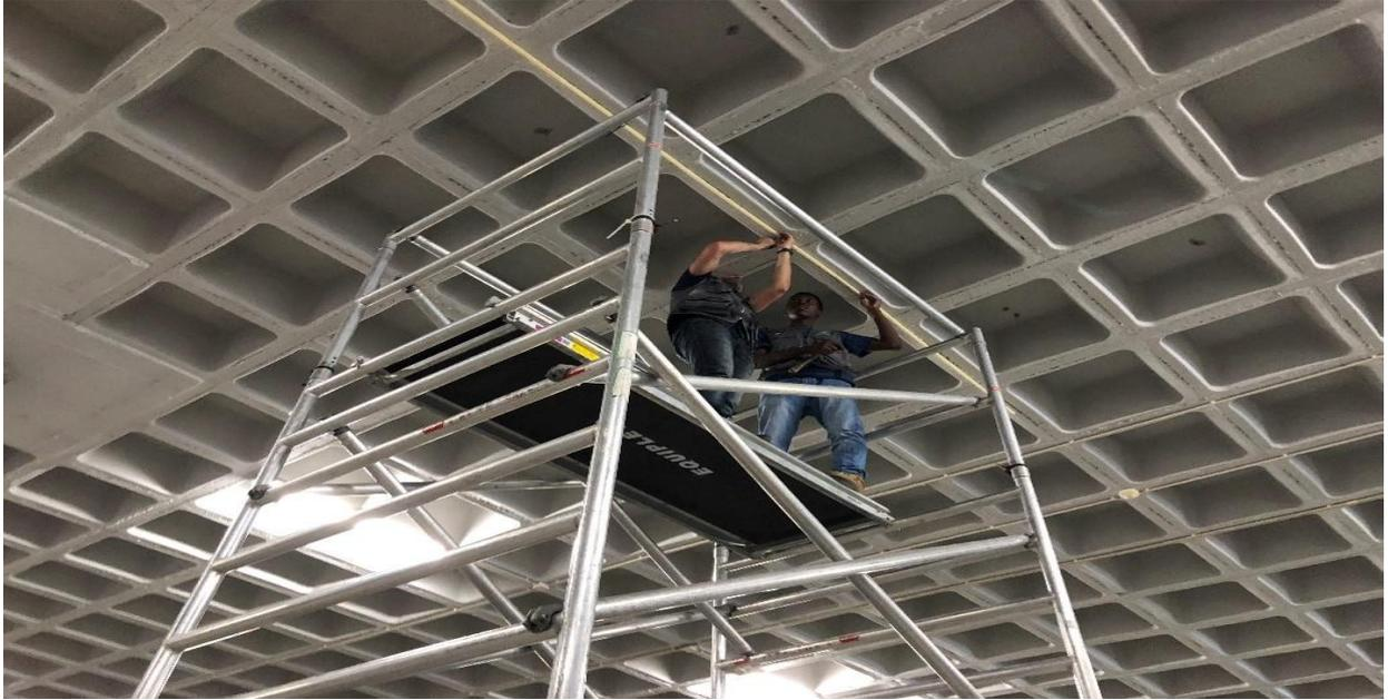
Imagem SEQ Imagem \\* ARABIC 36 - Abertura de furos e colocação de tubos VD16.
