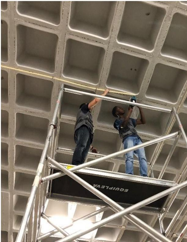
Imagem 53 - Aberturas de furos e colocação de tubos VD16.
